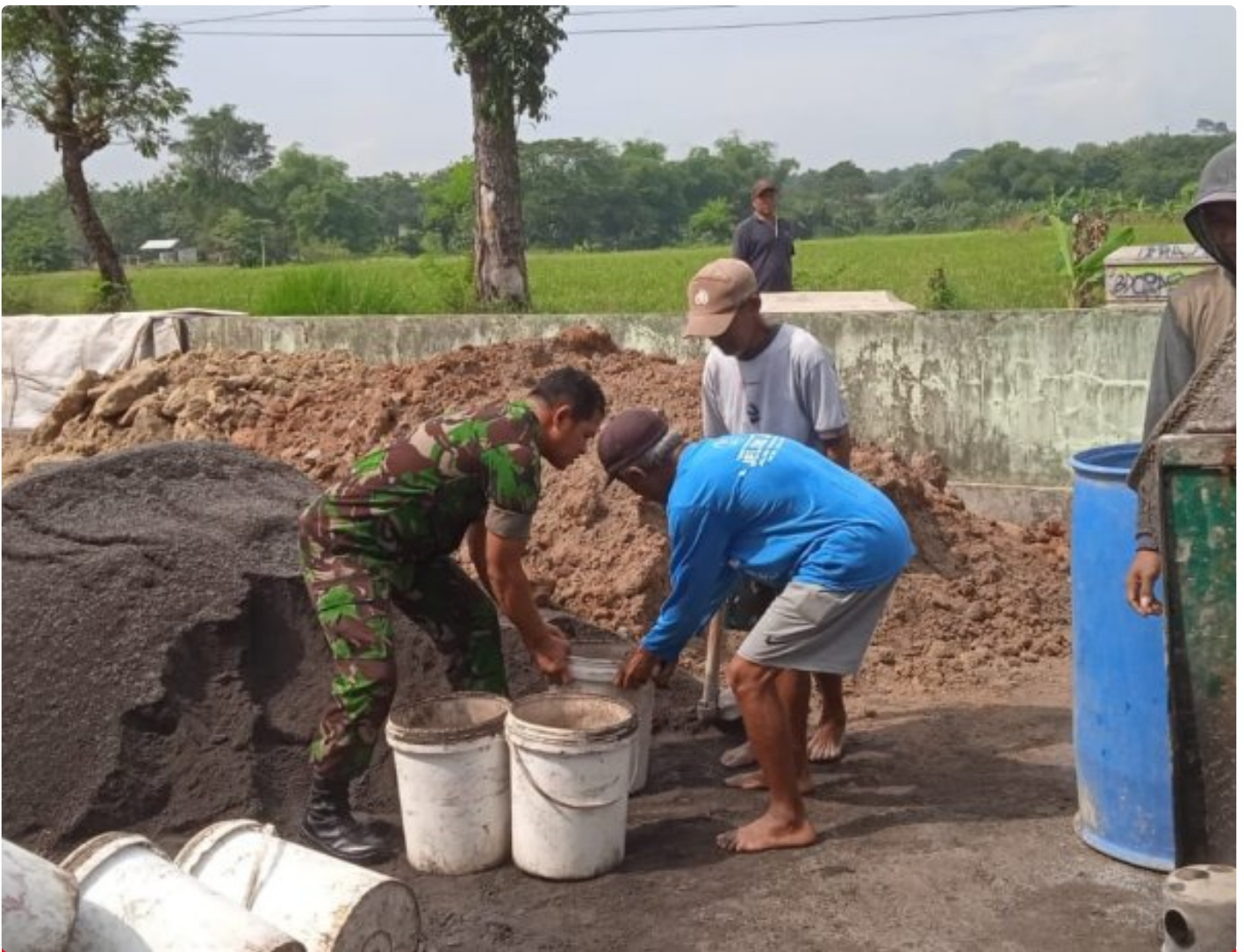
Wujud Kemanunggalan, Babinsa Wonosari Bantu Rehab Gedung Balai Desa Jelobo
